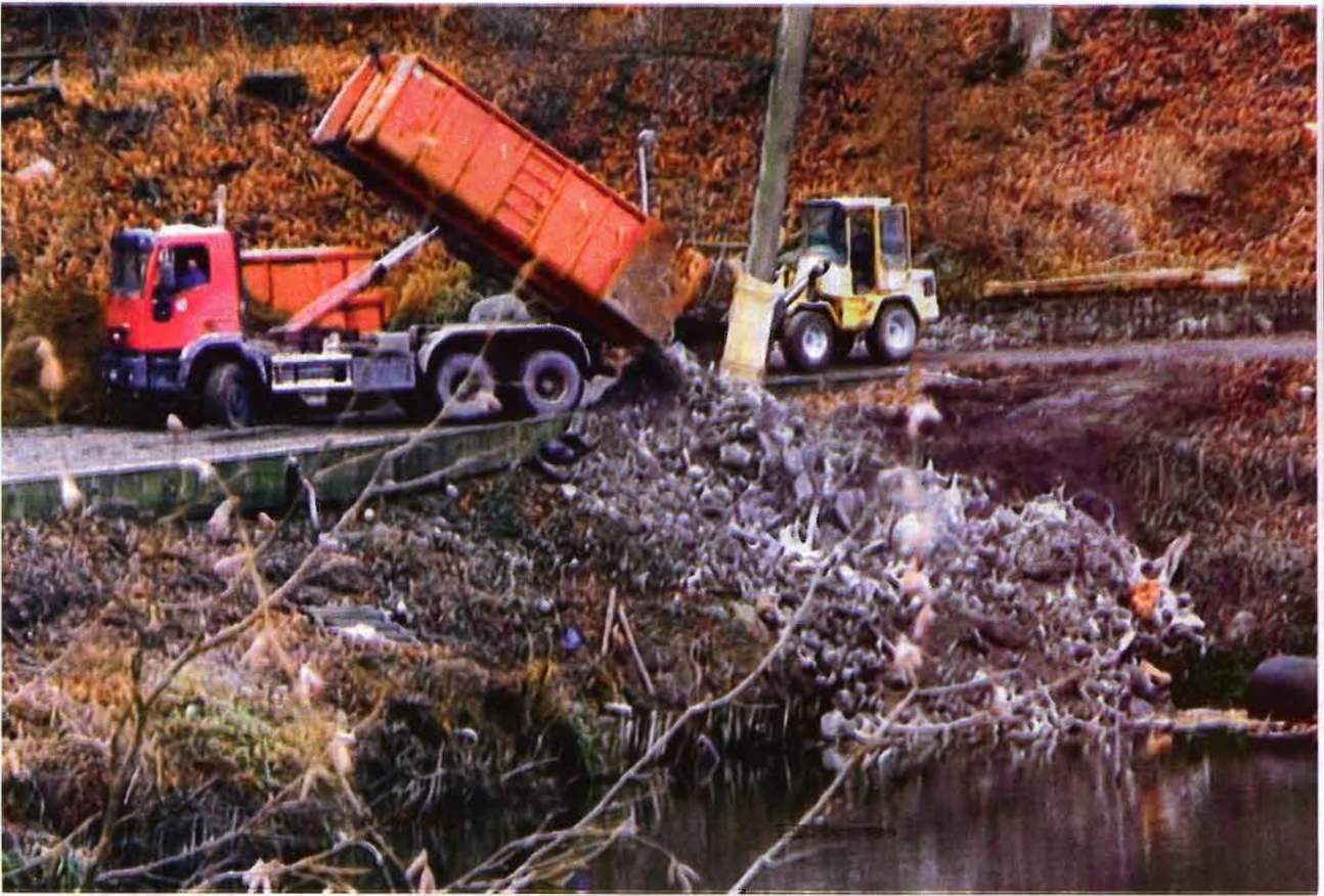
Abbruchmaterial wurde in den Teich nahe des einstigen Märchenwaldes im Phantasialand geschüttet.
